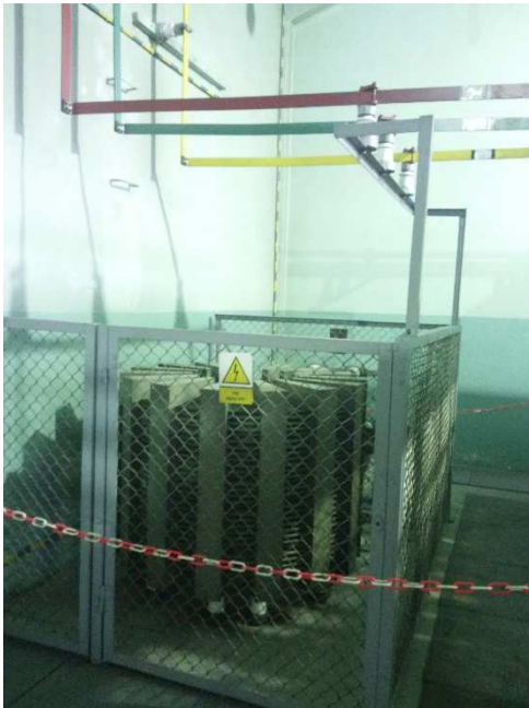
Rys. 2. Dławik typu XLEB4 120
