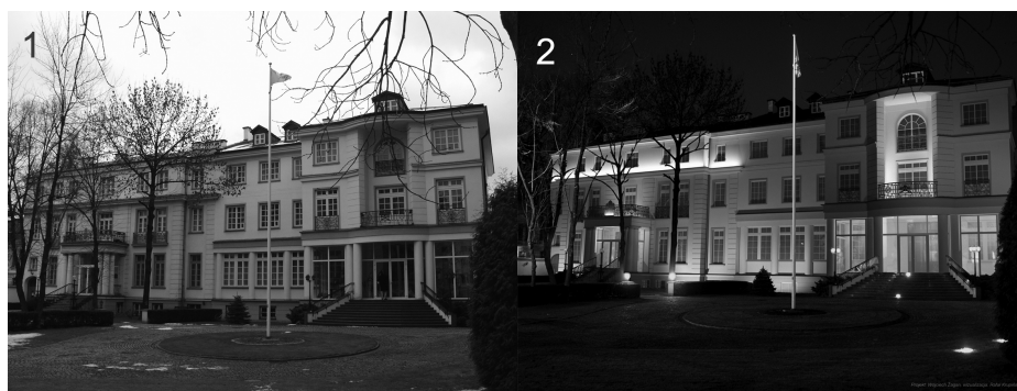
Rys. 1. Widok architektury obiektu: 1 - w porze dziennej, 2 - w porze nocnej (Fot. W. Żagan)
