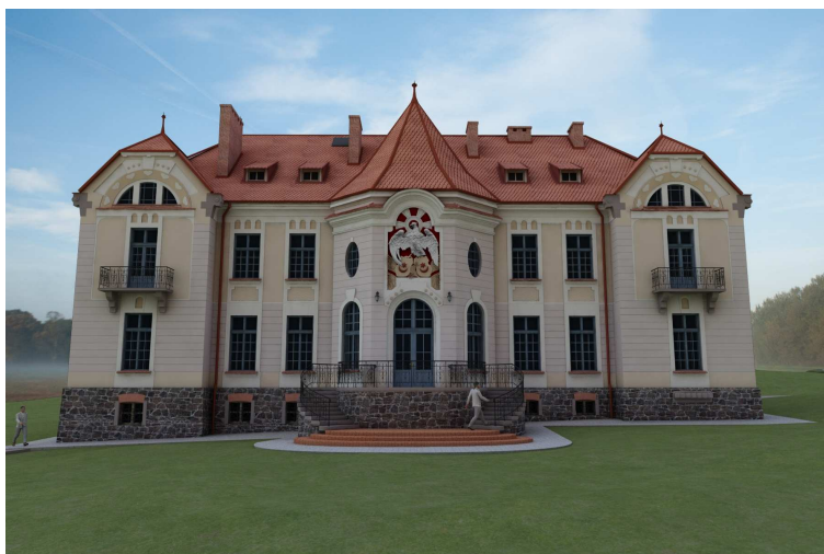
Rys. 3. Model komputerowy obiektu w świetle dziennym – widok frontonu [11]
